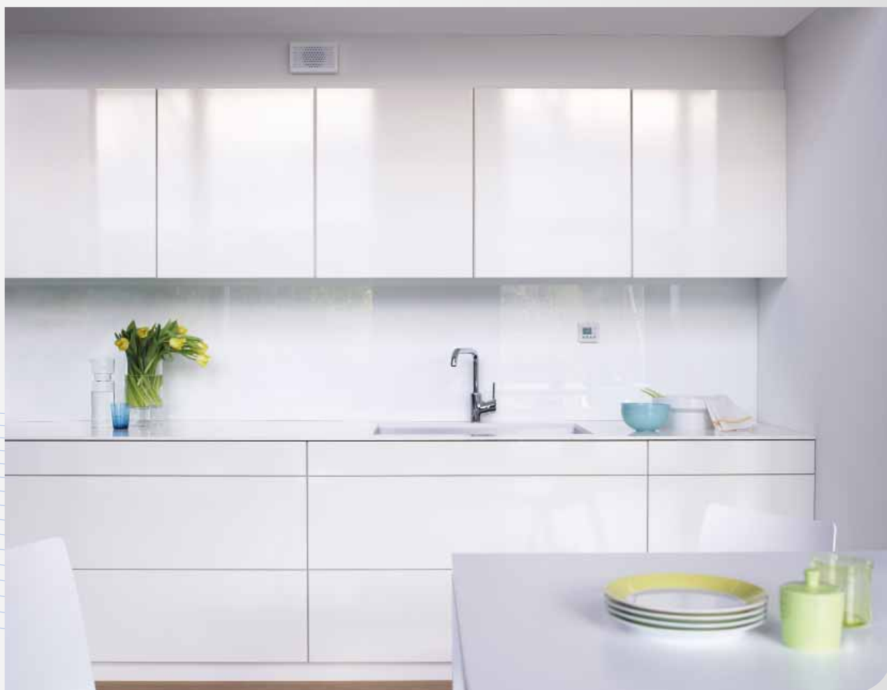
Instalace v kuchyni - zakrytá
