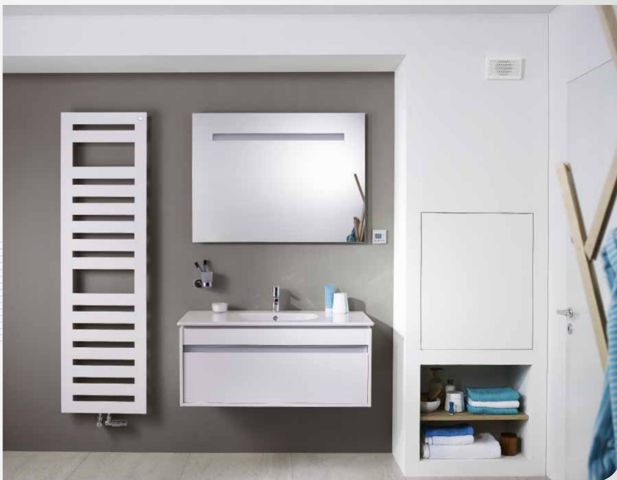
Instalace v koupelně - zakrytá
