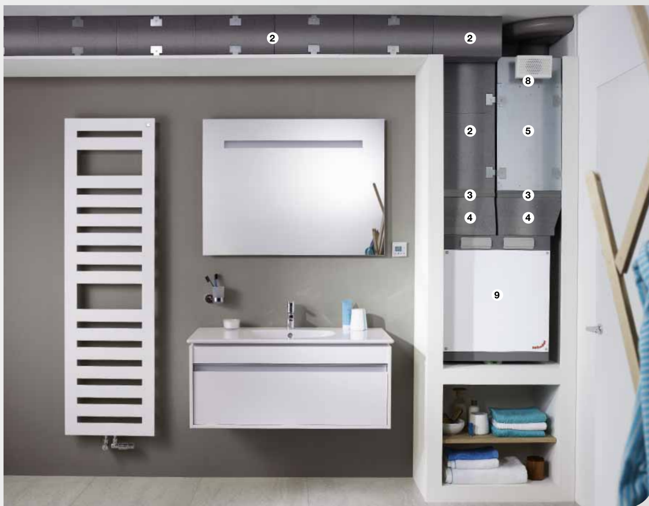
Instalace v koupelně - odkrytá
